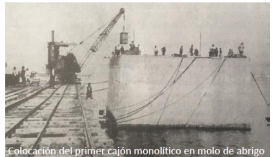
Colocación del primer cajón monolítico en molo de abrigo
