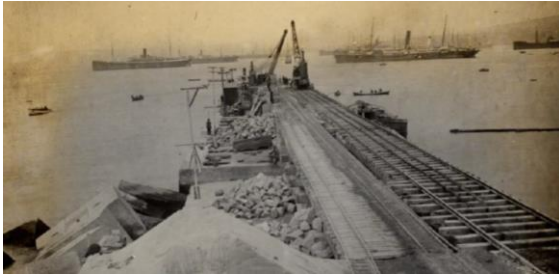
Relleno de un cajón con concreto
