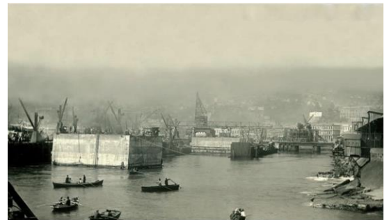
Colocación del primer cajón monolítico en molo de abrigo
