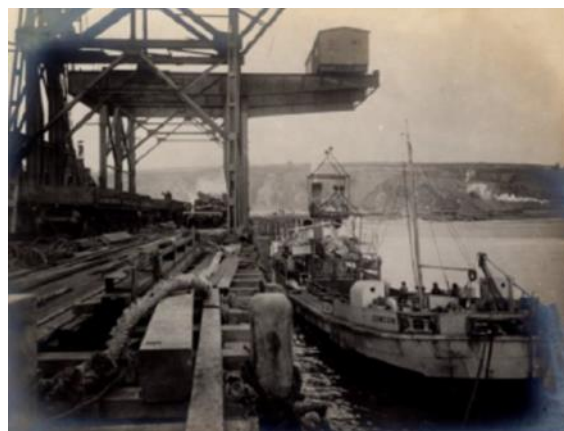
Cargando un Ganguil con enrocados en el Muelle de las Salinas
